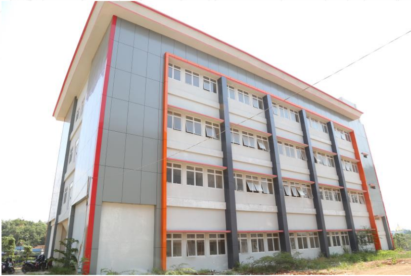
Pembangunan Rumah Sakit Pendidikan Universitas Lampung
