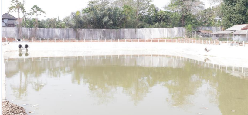
Pembangunan embung konservasi Universitas Lampung
